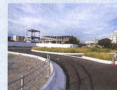
工事が進む幸手駅舎と西口広場
